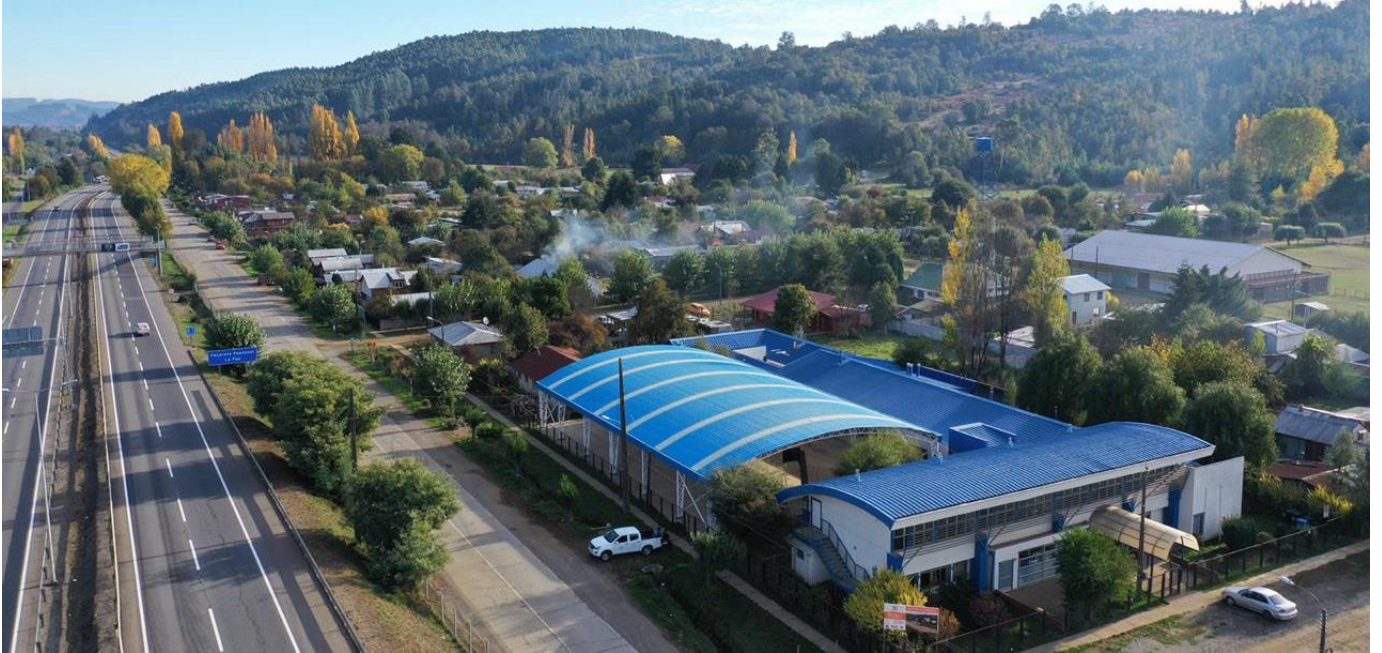
PATIO TECHADO – ESCUELA DOMITILA PINNA PARRA
